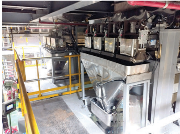
Hình 5: Hình ảnh trạm cân lớn (bên trong) và trạm cân nhỏ (bên ngoài) đang làm việc
