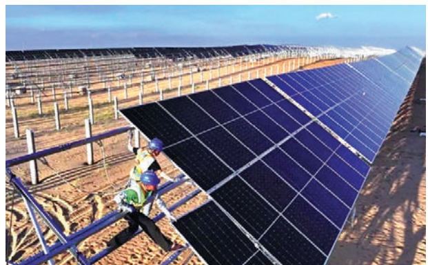
Công nhân lắp pin quang điện trên sa mạc Kubuqi. Ảnh: China Daily
