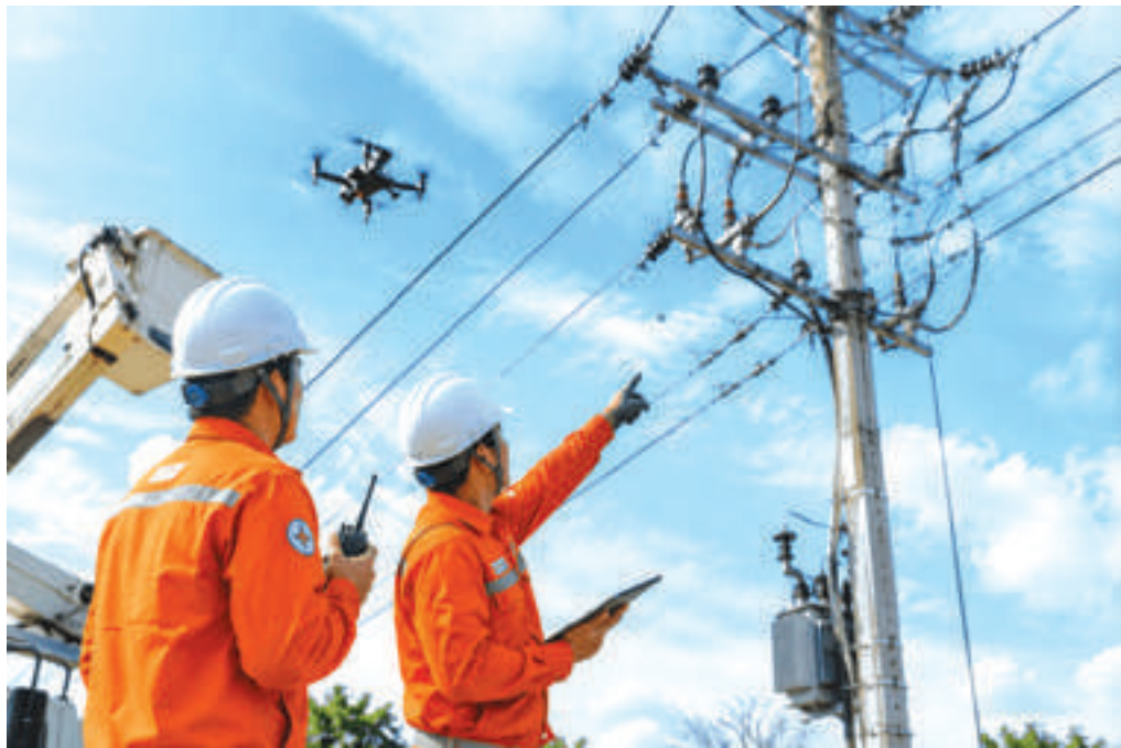
Công nhân điện lực kiểm tra lưới điện, chủ động ứng phó mùa mưa bão. Ảnh: Trâm Anh
