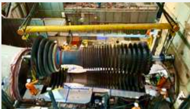
Tiến hành đại tu tổ máy GT21 Nhà máy điện Phú Mỹ 2.1
