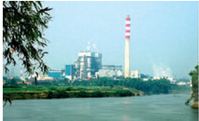
Điện lực TKV đang điều hành 6 nhà máy nhiệt điện và 1 nhà máy thủy điện với Tổng Công suất lắp đặt 1.735 MW
