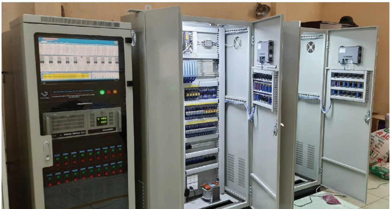
Hình 5. Hình ảnh lắp đặt hệ thống tủ điện tại Trạm điện Thành Công - Công ty Than Hòn Gai
