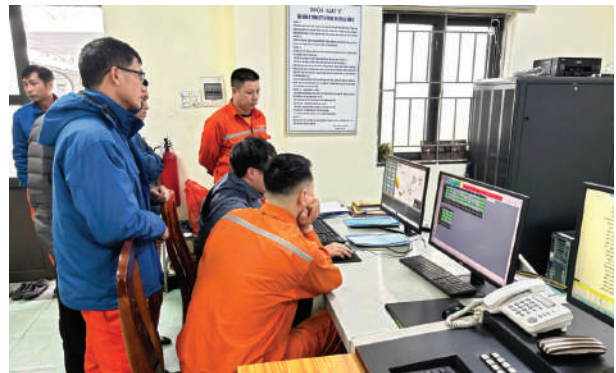
Hình 5. Hình ảnh hệ thống lắp đặt thực tế tại Công ty Than Mạo Khê
