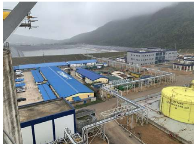
Hình 1: Tuyến ống dẫn xỉ ra ao tro thuộc hệ thống thải xỉ ướt, nhà máy Nhiệt điện Vũng Áng 2
