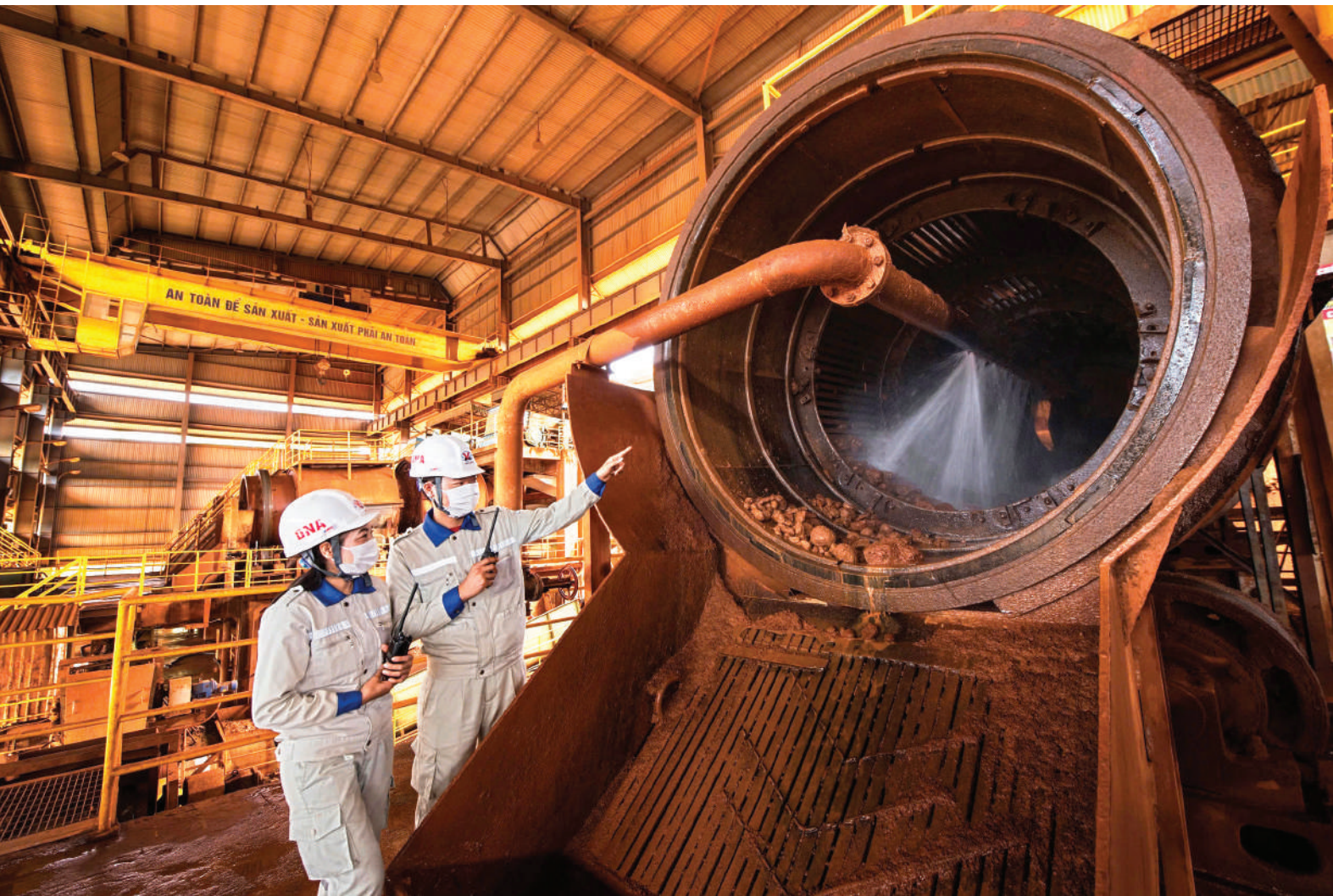
Công nhân Công ty Nhôm Đắk Nông - TKV thực hiện tuần kiểm thiết bị tại Nhà máy Alumin Nhân Cơ
